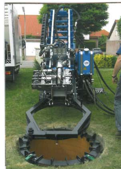
GEODRILL 4R wird auf den Schacht montiert ...
